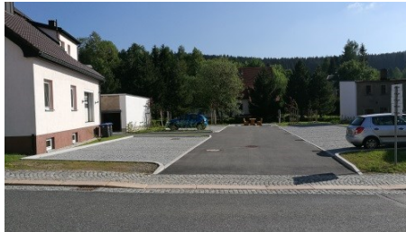
Ein neuer Parkplatz ist an dessen Stelle neu errichtet worden.
