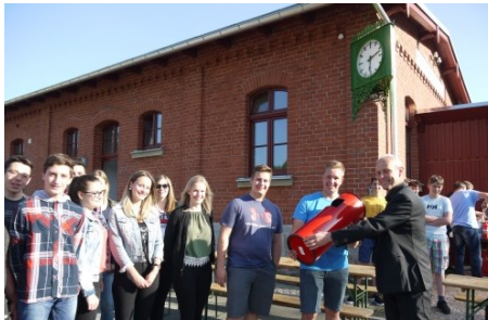
Das alte Bahnhofsgebäude erhielt mit Öffentlicher Toilette und Jugendclub eine neue Nutzung.
