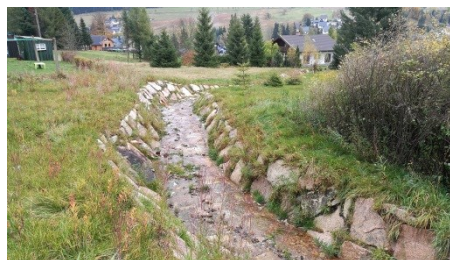
Bachläufe wurden saniert.
