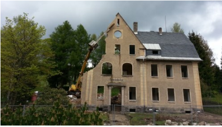
Das alte Gemeindeamt wurde abgerissen.
