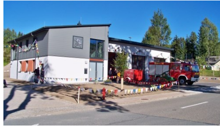
Ein neues Feuerwehrgerätehaus ist an dessen Stelle neu errichtet worden.
