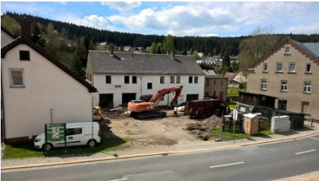
Das alte Gerätehaus wurde abgerissen.
