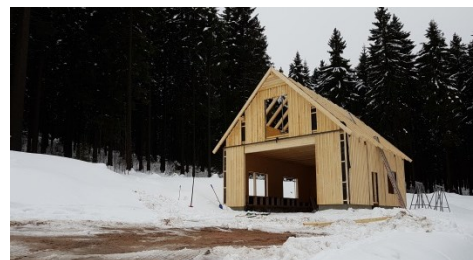
Für den Pistenbully entstand eine neue Garage.
